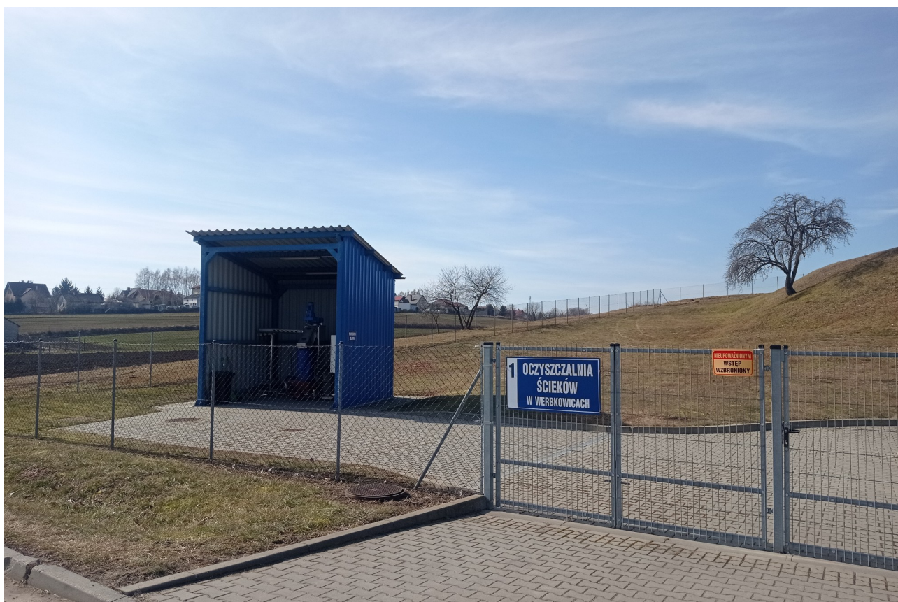
Zdjęcie nr 16. Oczyszczalnia Ścieków w Werbkowicach.
