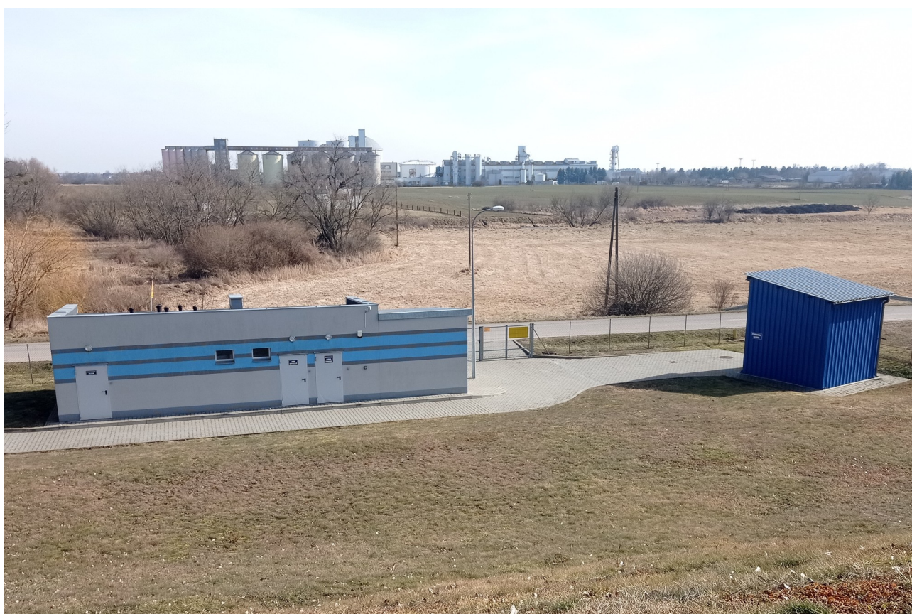
Zdjęcie nr 17. Oczyszczalnia Ścieków w Werbkowicach – budynek socjalny, sterownia.
