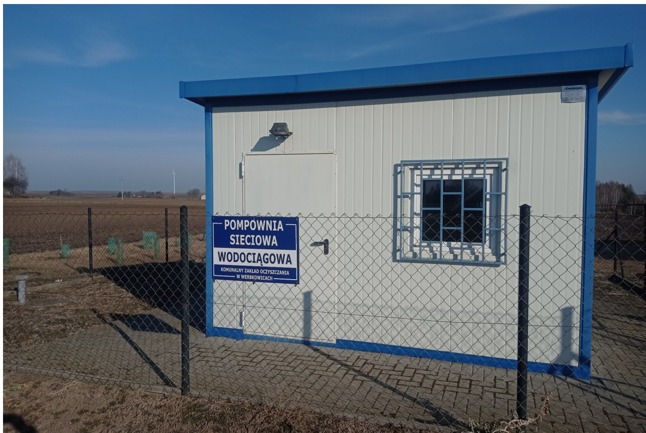
Zdjęcie nr 10. Pompownia sieciowa wody – Wilków.
