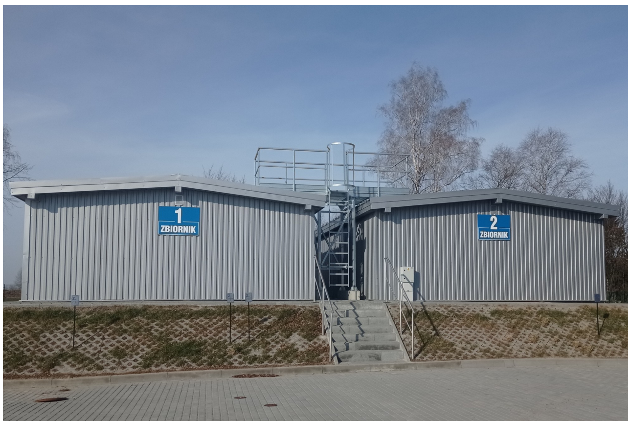
Zdjęcie nr 14. SUW Sahryń – zbiorniki wyrównawcze.
