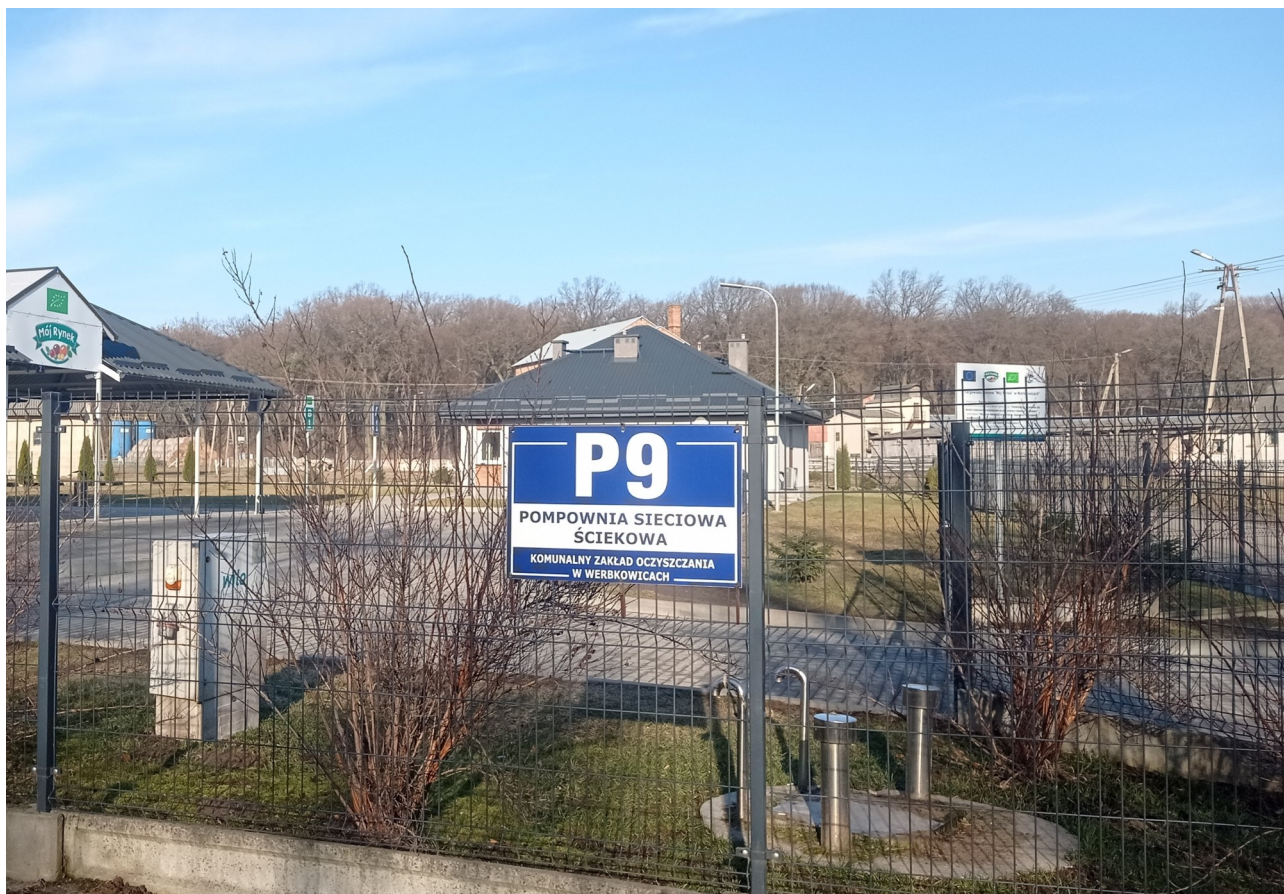
Zdjęcie nr 20. Przepompownia Ścieków ul. Piłsudskiego.
