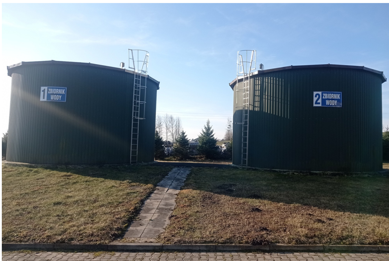
Zdjęcie nr 8. SUW w Werbkowicach – zbiorniki wyrównawcze.
