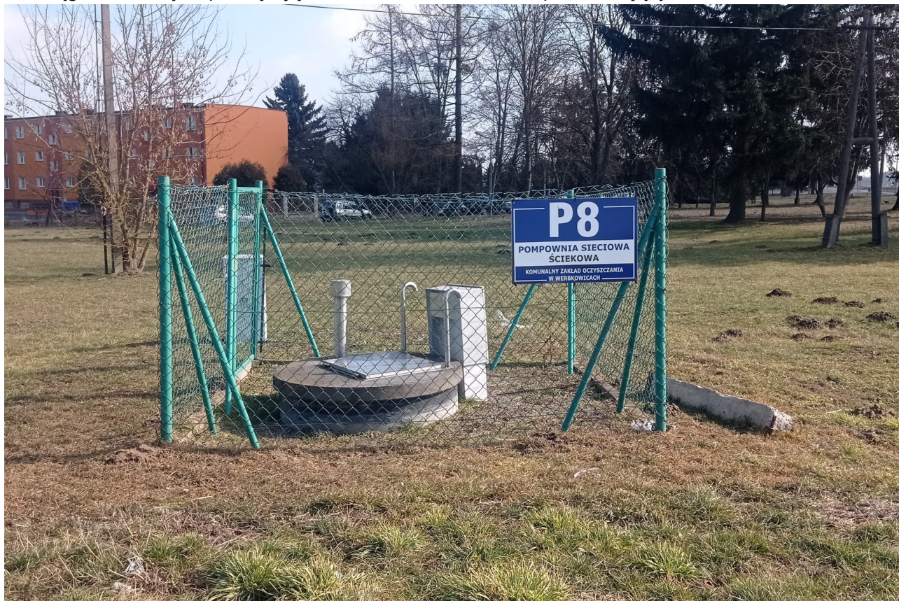
Zdjęcie nr 19. Przepompownia Ścieków ul. Przemysłowa.
