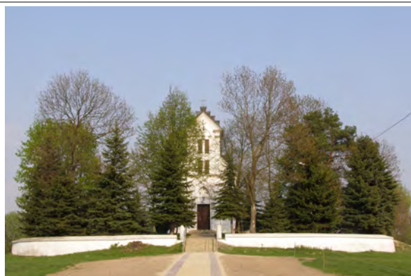
Kaplica Grobowa w Malicach
