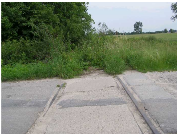
Rys. 10. Przejazd przez tory kolejowe
