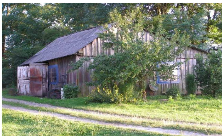
Rys. 18. Obecny budynek kuźni.
