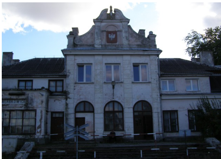
Rys. 19. Budynek stacji kolei w Werbkowicach
