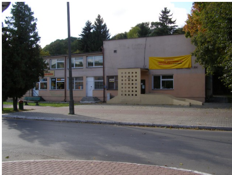
Rys. 12. Gminny Ośrodek Kultury w Werbkowicach przed termomodernizacją
