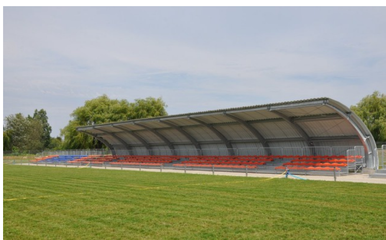
Rys. 27.1 Boisko po remoncie i modernizacji
