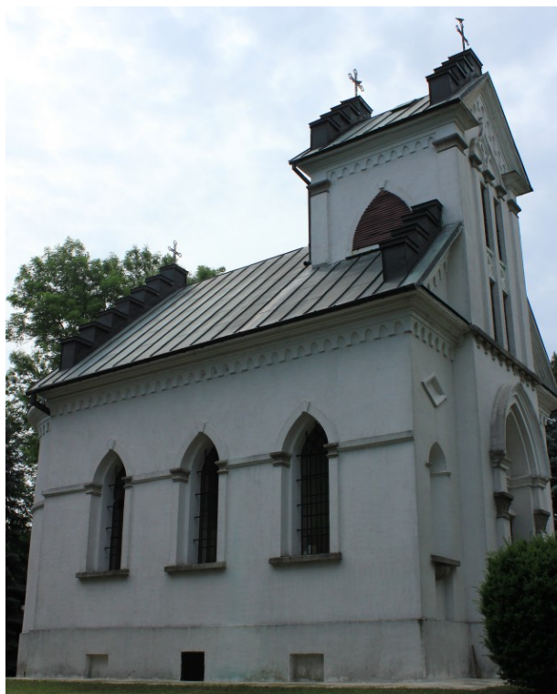
Rys. 9. Kościół w Malicach
