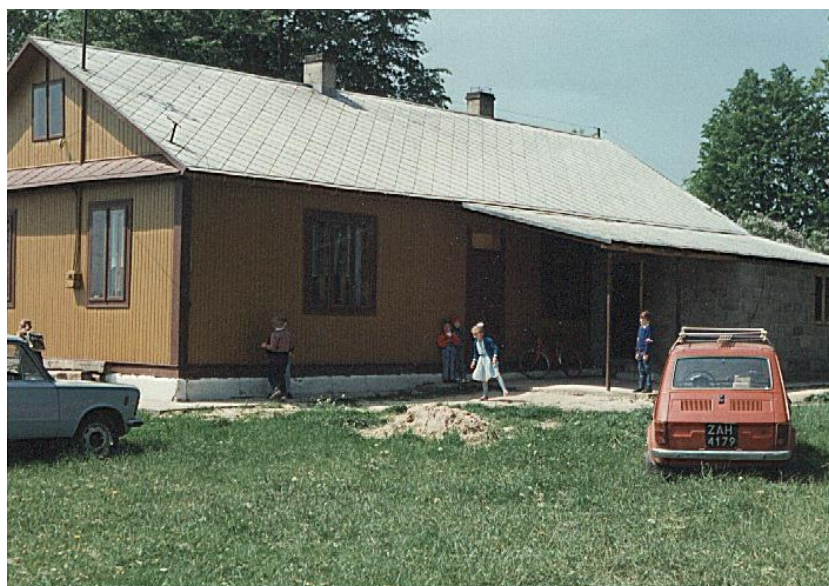
Rys. 18.: Budynek szkoły po remoncie, który funkcjonował w latach 1990 – 1998.
